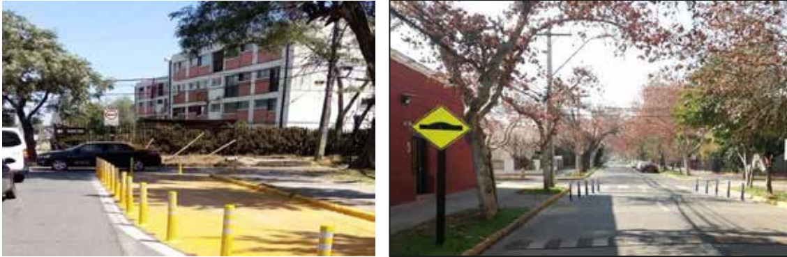
Instalación Chicana en Calle Colo Colo con Tegalda.
