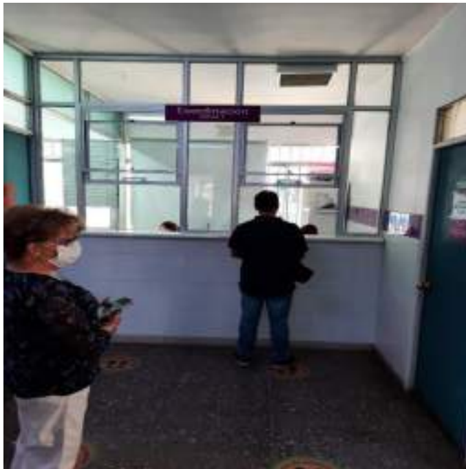
Mejoramiento de sala de espera y construcción de nueva oficina de coordinación en sector 1.
