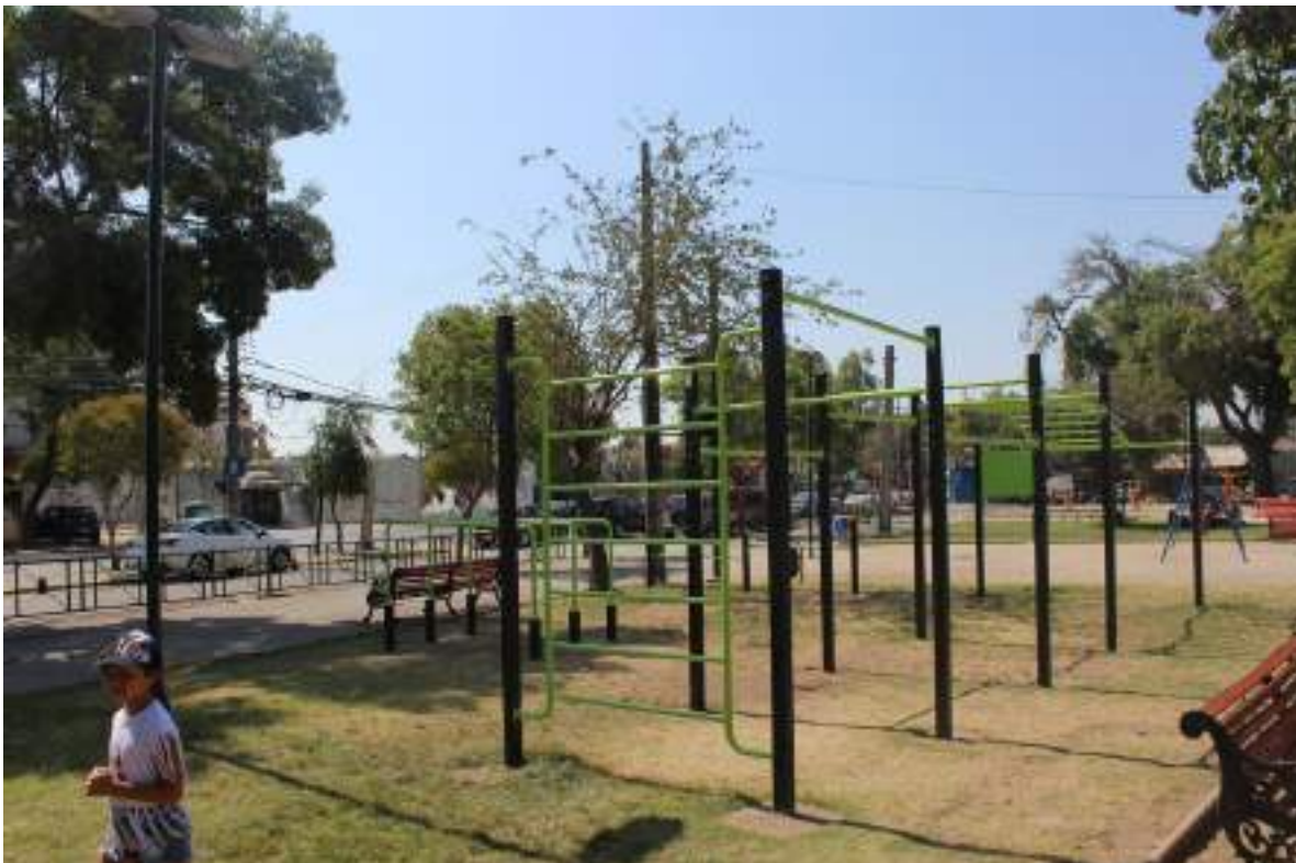
FIGURA / Instalación calistenia en Plaza Zañartu
