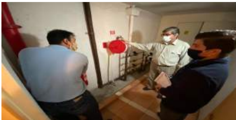
Levantamiento de Condiciones de Seguridad Edificio Chile España N° 537
