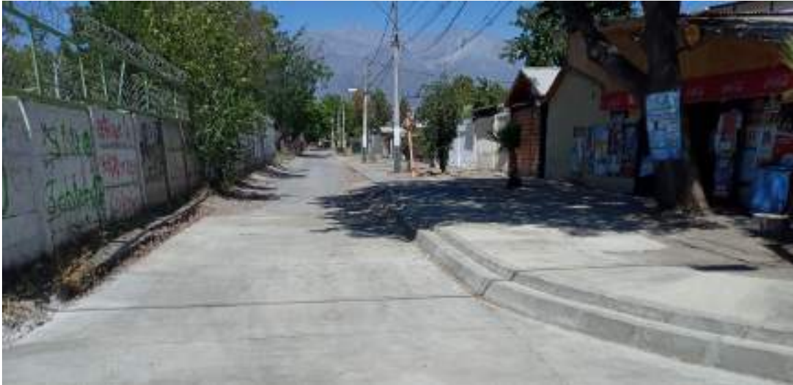
Calle Pichidangui, en intersección con calle Brown Sur
