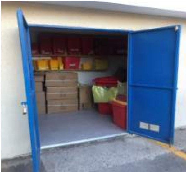
Sala de REAS equipada y en funcionamiento
