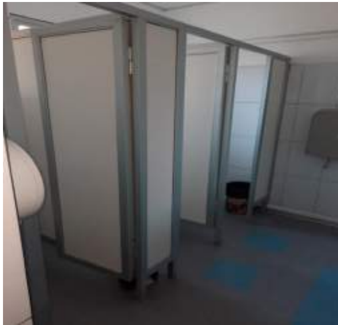
Baño de mujeres en sala de espera sector 2: Instalación piso vinílico, cambio de sanitarios, instalación de mudador, cambio de ventanas.
