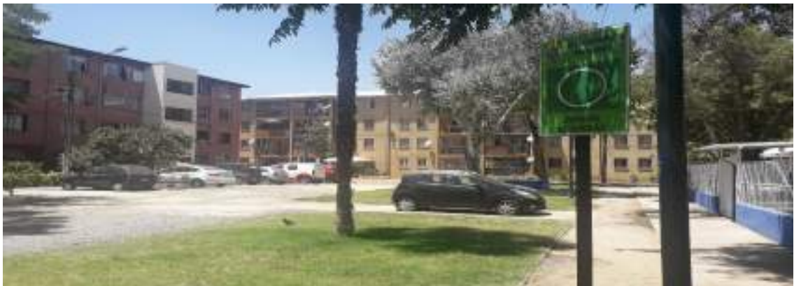
Zona de Seguridad Copropiedad Lo Encalada N° 1855 Interior
