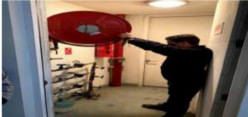
Levantamiento Condiciones Seguridad Edificio de Sucre N° 2380
