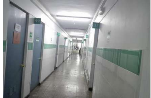
Reparación de muros y pasillos Sector 5 y Sector 2, por $6.043.843.-
