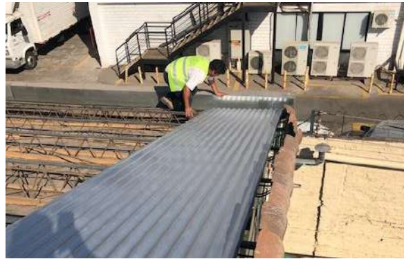
Cambio de cubierta Centro de Rescate Canino.
