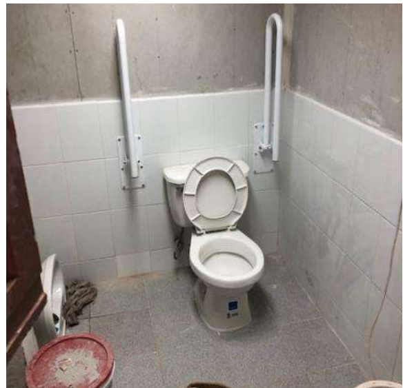
SS.HH. inclusivo Pedro de Valdivia N°3636.
