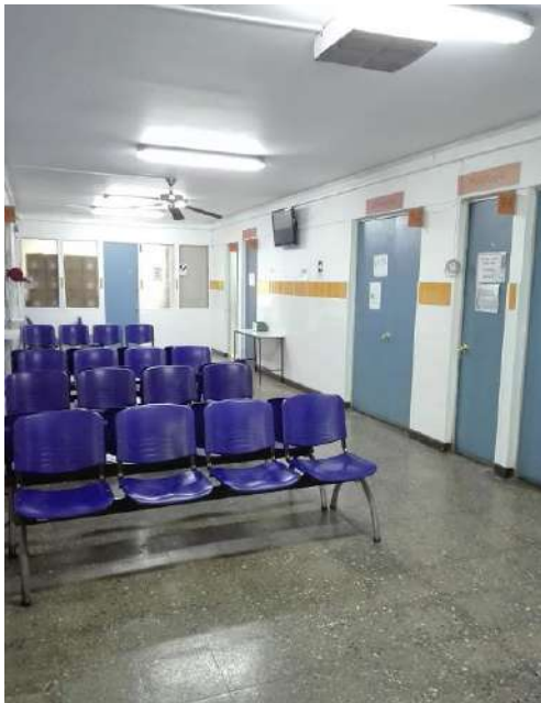
Instalación de equipos y luces LED en pasillos y salas de espera. $3.341.520.-
