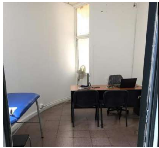
Mejoramiento de box de atención que contempla la instalación de mobiliario, pintura hospitalaria y delimitación de área limpia y sucia.
